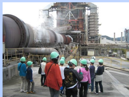
住友大阪セメント(株)赤穂工場のロータリーキルンとプレヒーター見学の様子
